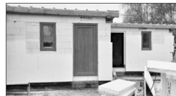
Výstavba sociálního zařízení na cvičišti. Foto: SDH
