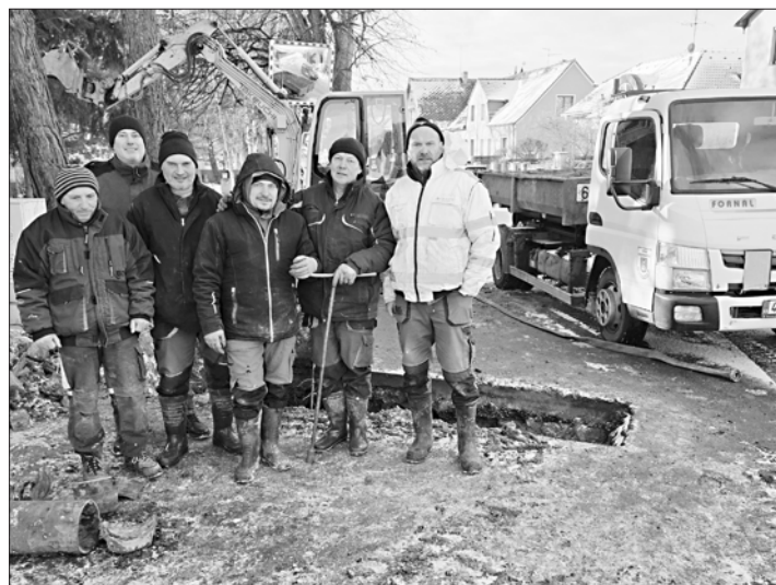
Tým pracovníků střediska Vodní hospodářství města Rožmitál pod Třemšínem po opravě poruchy na hlavním přivaděči. Prováděli ji ve velmi náročných klimatických podmínkách. Foto: Aleš Haluska
