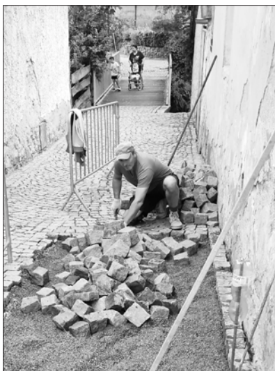
Oprava dlážděného chodníku u zrekonstruované lávky pro pěší v centru města.
