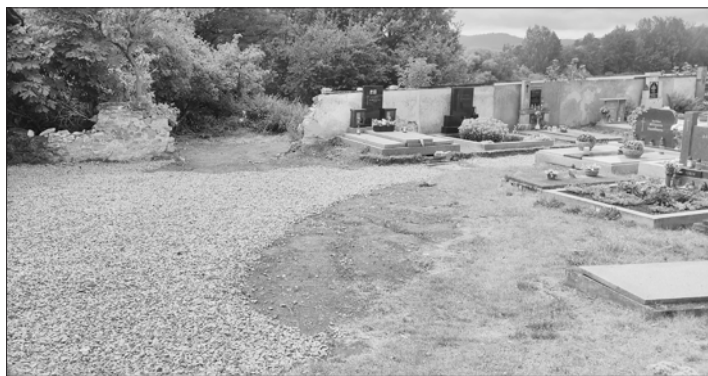
Budování nového chodníku a místa pro posezení na starorožmitálském hřbitově.
