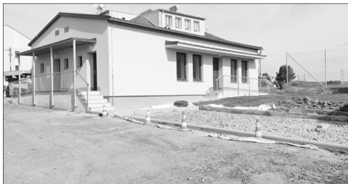
Práce v Pňovicích u bývalé prodejny, kde vznikly nedávno tři nové byty. Snímky: Aleš Haluska
