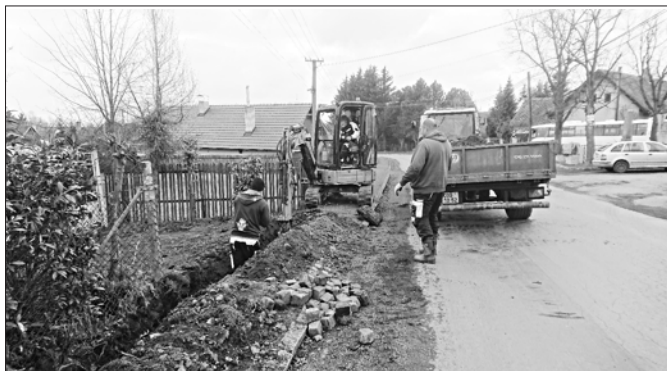
V BUKOVÉ započali pracovníci firmy Elektrostav Strakonice s. r. o. s prováděním zemních prací na přeložce rozvodů NN. Foto: archiv obce
